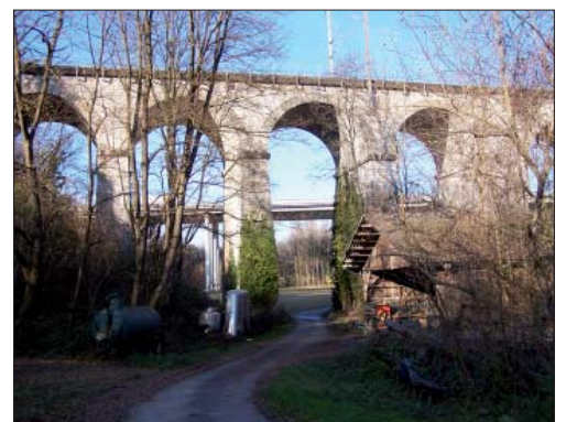
Viaduc (pont ferroviaire) - note 2
