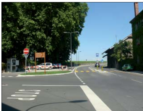
Intersection route Suisse / Grand Rue
